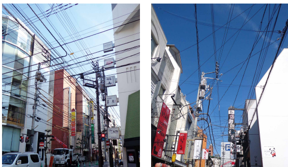
松山市二番町辺りの電柱、電線の様子
