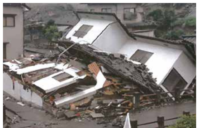
平成28年熊本地震で倒壊した木造住宅
