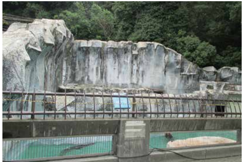
改修予定のアシカ舎(2018年10月)
