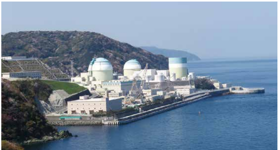
伊方町亀浦付近から見た伊方発電所(写真提供:四国電力)
