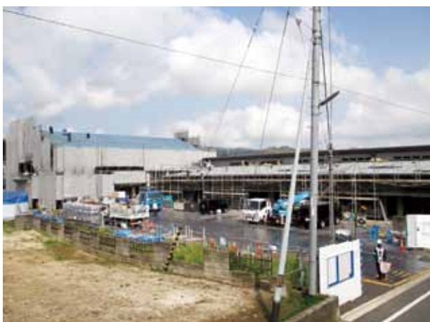
開設に向けて工事が進む業技術センター
