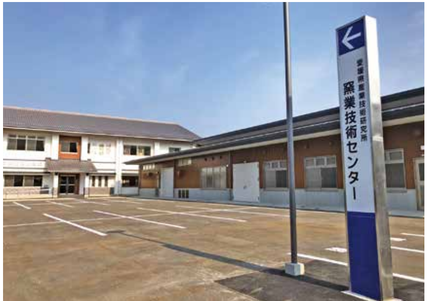
ほぼ完成した新窯業技術センター(2019年6月撮影)
