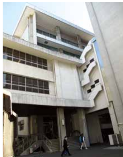
現在地に建て替えるためR2年度当初予算に設計調査等の経費が計上された県庁第2別館(写真奥の建物)
