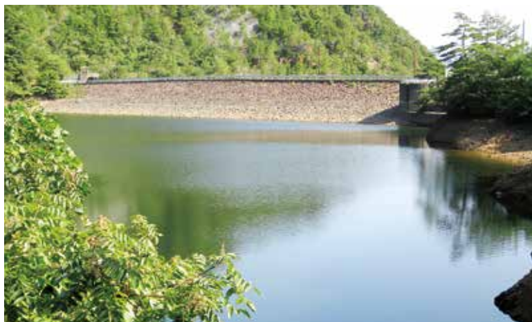
昭和53年1月に完成した銚子ダム。貯水量77万立方メートル。前方に見えるのがダム堤（令和3年9月撮影）
