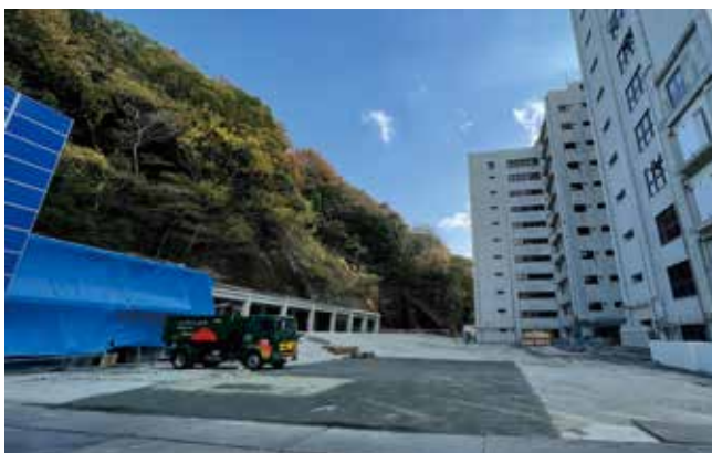
▲旧第二別館の解体が終わり整地された建設予定地（令和5年11月撮影）
